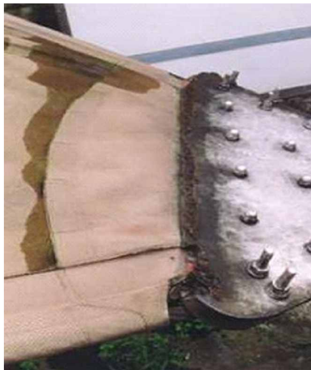
Obr. 9 | Vysokokvalitná oceľ podľahla korózii tropického podnebia haly postavenej v roku 1982 v oblasti rovníkovej Afriky
