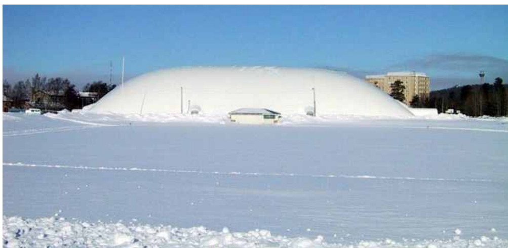
Obr. 7 | Nafukovacia športová hala 100 x 60 x 18 m, Kuopio, Fínsko
