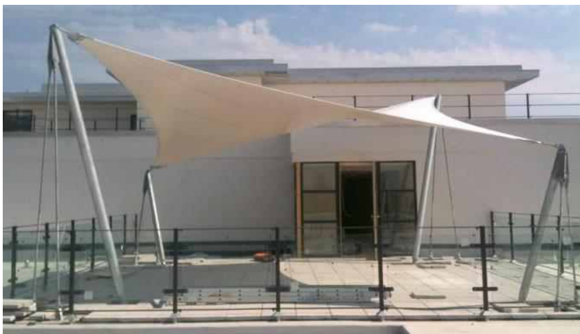
Obr. 01 Zajištění celkové tuhosti konstrukce pomocí dvojic táhel nebo rámovým rohem
