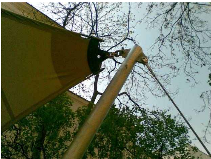
Obr. 07 | Koncové detaily sloupů - přípoj šikmého lana a uložení na čep
