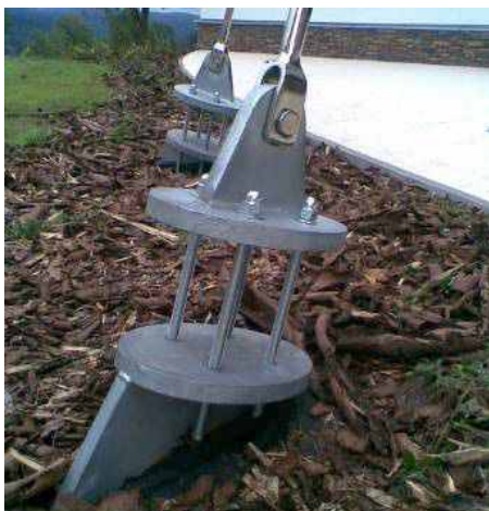
Obr. 08 | Rektifikační prvek, napínák a dělená patka s vysokopevnostními šrouby
