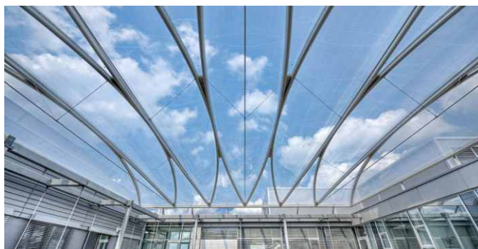
Obr. 6 | Pneumatická konstrukce - fólie ETFE
