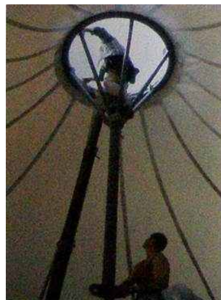
Obr. 21 | Způsob vnesení předpětí zvětšením rozměru
