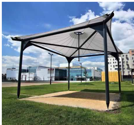
Obr. 01 Zajištění celkové tuhosti konstrukce pomocí dvojic táhel nebo rámovým rohem
