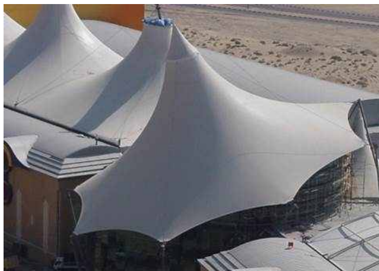
Obr. 5 | Dvě opačně zakřivené povrchy předeptuté proti sobě - kuželová membrána
