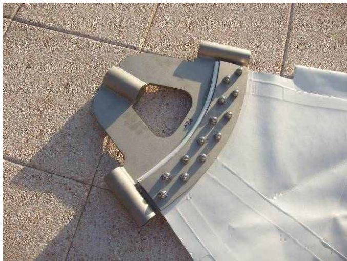
Obr. 04 Nárožní kotvení membrány k ocelové konstrukci
