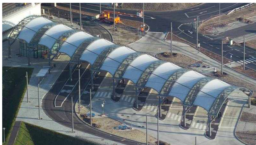
Obr. 6 | Dvě opačně zakřivené povrchy předeprnuté proti sobě - membrána na obloucích
