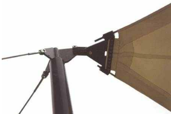
Obr. 16 | Bodové uchycení - lana, táhla
