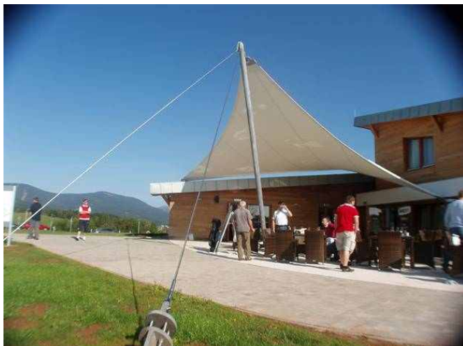
Obr. 06 | Hyperbolický paraboloid se čtyřmi kotevními body v rozích
