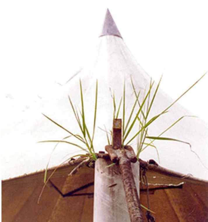
Obr. 9 | Vysokokvalitná oceľ podľahla korózii tropického podnebia haly postavenej v roku 1982 v oblasti rovníkovej Afriky
