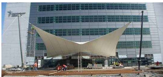
Obr. 12 | Příklad kotvení membránové konstrukce - ocelové prvky
