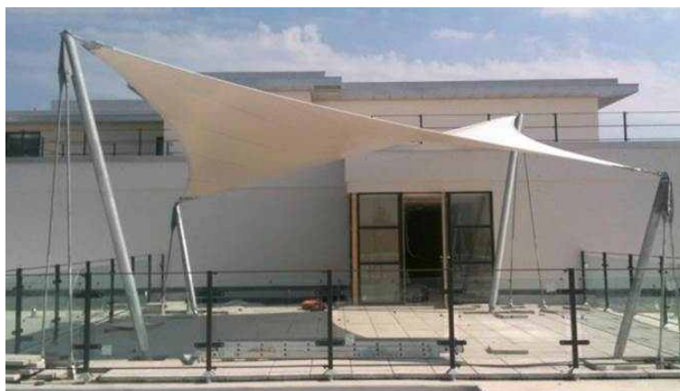
Obr. 4 | Bodově uchycená plachta - hyperbolický paraboloid
