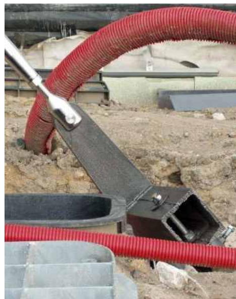
Obr. 09 | Kotvení pomocí zemních vrutů
