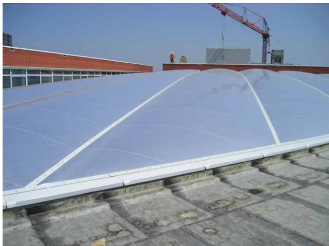
Obr. 3 | Standardní šířka elementu 3,5m, délka až 50m
