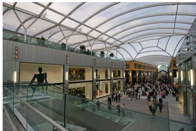
Obr. 4 | 3 - vrstvá střecha – Elements, Livingston, Anglie
