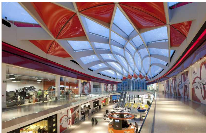
Obr. 4 | 3 - vrstvá střecha a fasáda - Médiacité, Liege, Belgie (2007)
