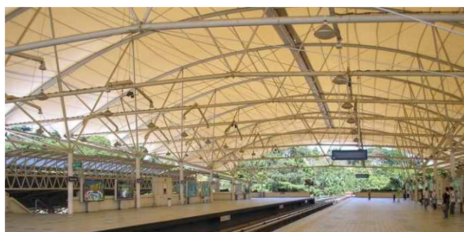
Obr. 13 | Tuhá nosná konstrukce
