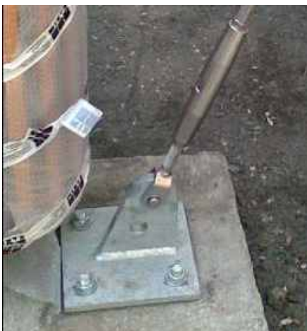
Obr. 08 | Rektifikační prvek, napínák a dělená patka s vysokopevnostními šrouby
